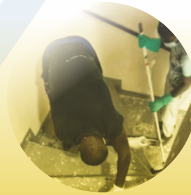
2 e phase / Nettoyage des 8 étages
