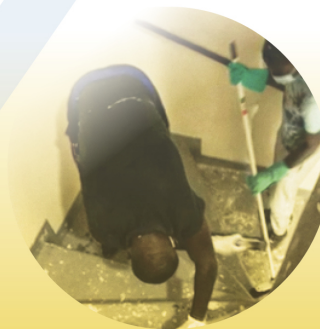
2 e phase / Nettoyage des 8 étages
